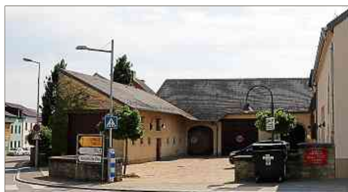
In einer zweiten Phase werden der hintere Mittelteil und der linke Gebäudeflügel des Henkesbaus modernisiert. Foto: Pierre Mousel
